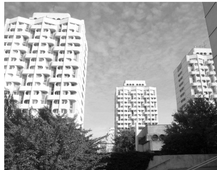
Vratislav, Grunwaldské náměstí 4–16, arch. Jadwiga Grabowska-Hawrylak, Ing. K. Sasiadek, 1968–1978. Bytové domy jsou zatepleny, barevná i materiálová změna proběhla se souhlasem autorky [foto H. Řepková, 2018]
