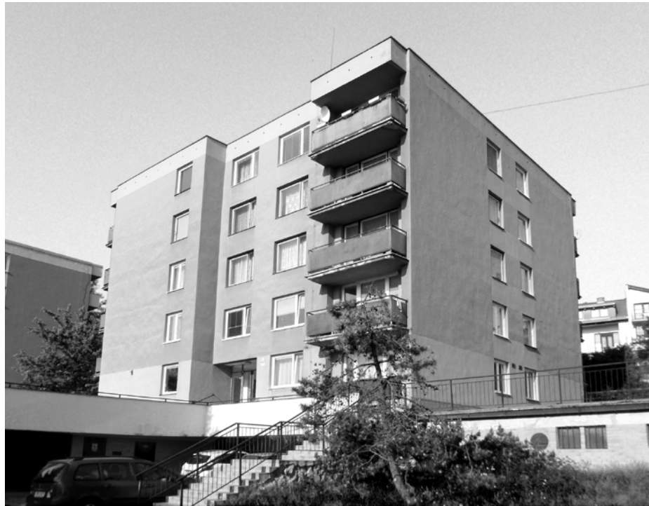
Punkthäuser in der Úprkova-Straße – ursprünglicher Zustand [ Foto A. Guzdek, 2013 ]
