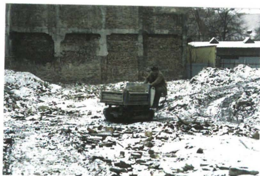
14. ZD a boom malé mechanizace. Výzkum ve Vodičkově ulici, 1. polovina 90. let 20. století.
