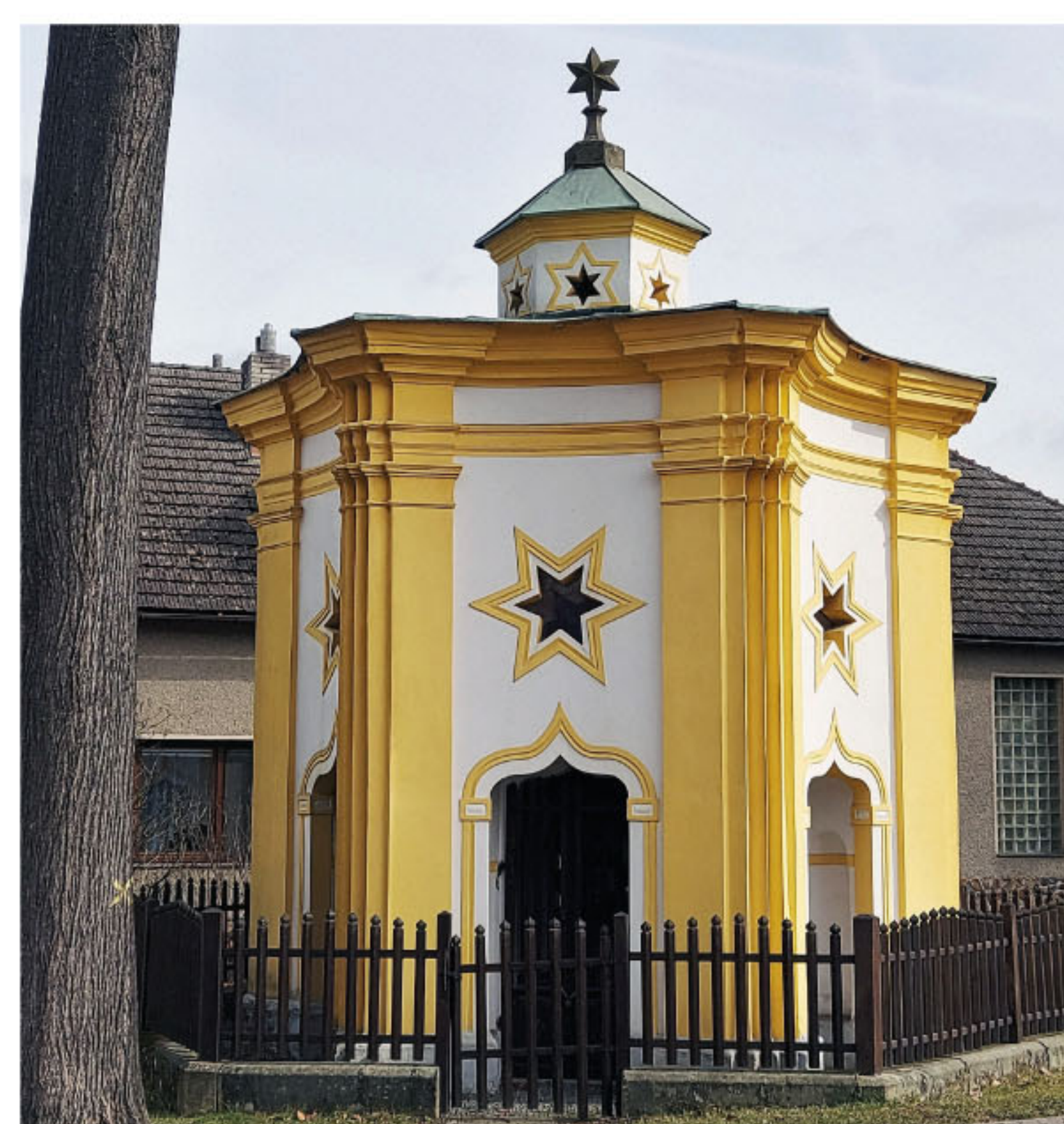
Běstvína, kaple sv. Jana Nepomuckého. Postavena byla po roce 1720. Pro svou barokně gotickou podobu i expresivnost použité symboliky byla připisována Santinimu. Jeho autorství však nic nepotvrzuje. Stavbu lze nejspíš spojit s kutnohorským stavitelem Janem Jakubem Voglerem, který Santiniho styl dobře znal, protože podle jeho plánů přestavoval klášterní kostel v Želivě a stavěl cisterciácký klášter v Sedci u Kutné Hory.
