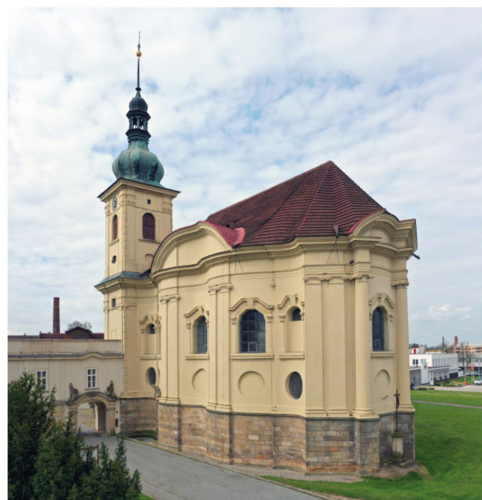
Smiřice, zámecká kaple Zjevení Páně. Elegantní novostavba na dynamicky zvlněném půdorysu byla postavena v letech 1699–1711 na zadání Jana Josefa hraběte Šternberka. V současnosti je za autora stavby považován Kryštof Dientzenhofer. Nepřekvapí proto doložená účast Santiniho bratra Františka Jakuba na kamenické výzdobě kaple, oba spolupracovali i na dalších významných stavbách.
