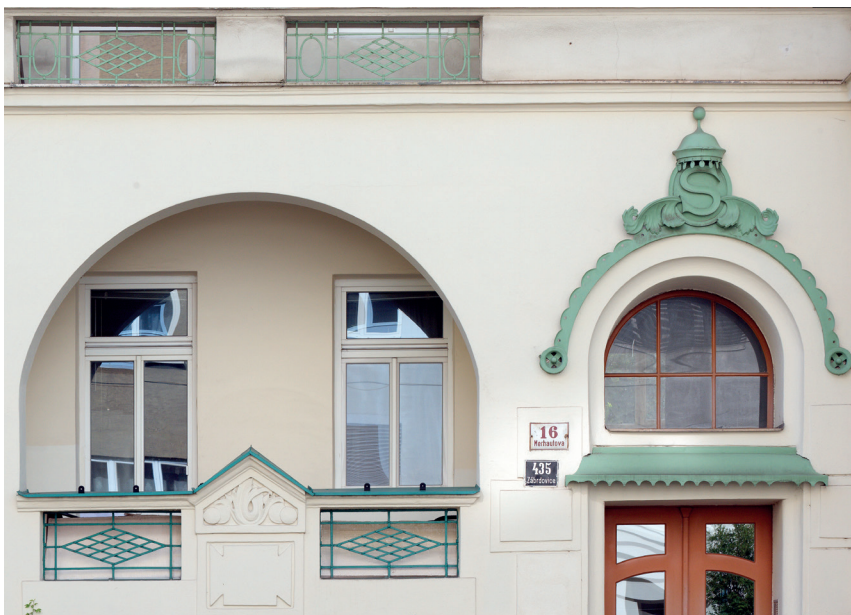
←↑ Pohled na zástavbu severní strany ulice Merhautovy, foto Martin Kučera 2024.
