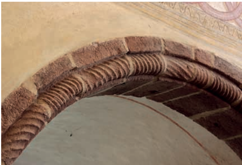
Obr. 6. Rovná (okres Praha-východ), kostel sv. Jakuba Většího, archivolta dolního oblouku s nápadně nenavazujícími úseky torovaného oblouku. (Foto Milan Falta, 2010)
