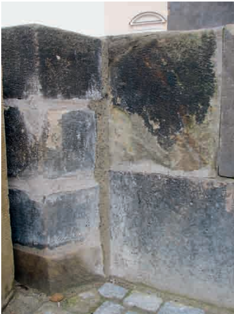
Obr. 1. Kamenné zábradlí Karlova mostu po provedené opravě. (Foto A. Křížová, 2008)
